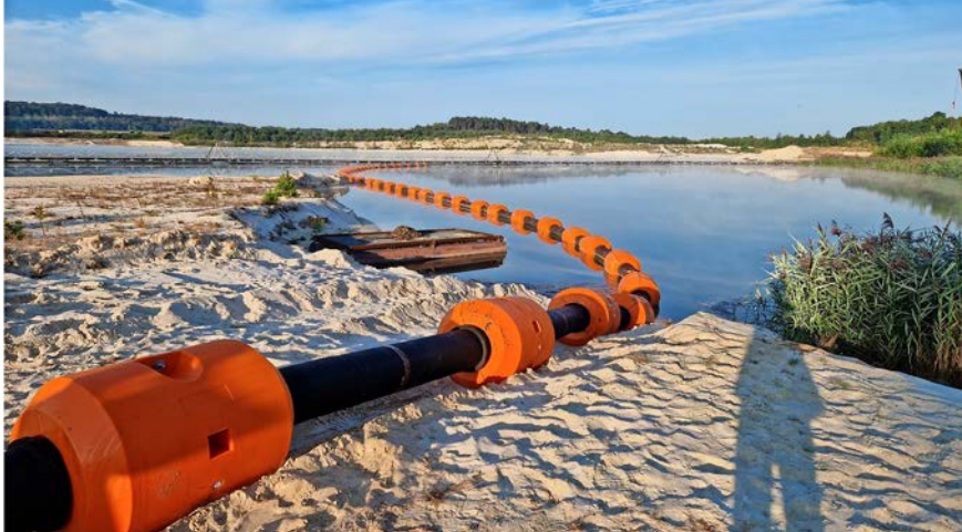
Gummischläuche sind bei der Nassgewinnung flexibel einsetzbar
